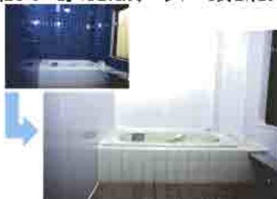
水周りの壁用リフォームパネル施工例 (キョーテックグループのホームページより転載)
